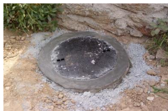
Figura 31 - Exemplo das fases de instalação duma caixa de ramal com tubo corrugado de elevação DN400 SN4
