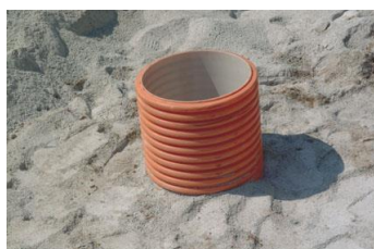
Figura 31 - Exemplo das fases de instalação duma caixa de ramal com tubo corrugado de elevação DN400 SN4
